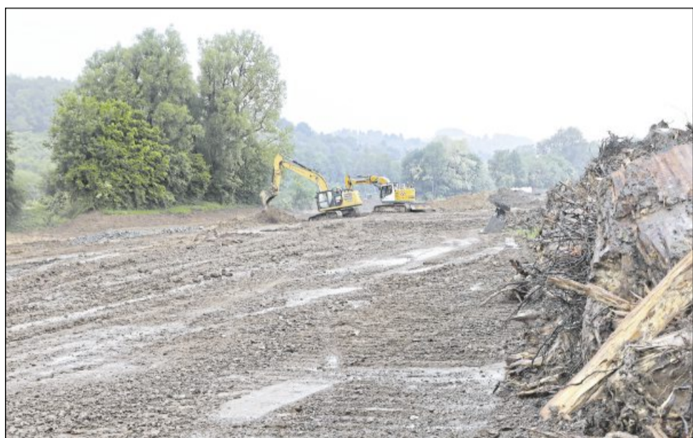
Baggerschaufel für Baggerschaufel entsteht die neue Gestalt der Rems.
